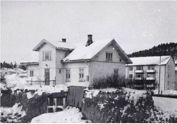
◀ Solheim gård – Trondheimsveien 275 - sto til byggingen av samfunnshuset tvang frem en riving i 1970. Det var Sølfest Forberg som kjøpte gården av Walle. Han hadde drevet svineoppdrett sammen med broren på Mellom-Hovin og fortsatte med det på Solheim. Også hans familie var stor; det ble etter hvert syv barn. Nærheten til travbanen gjorde at hestene etter hvert overtok grisenes plass. Foto Harald M. Nygaard. Bildet finnes i Groruddalen historielags billedatabase.
