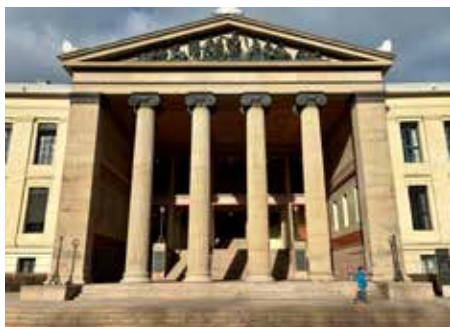
Inngangspartiet til Universitetets aulabygg består av vakker grorudgranitt levert av Borrebækken i første halvdel av 1840-årene. Foto: Tor Paulsen.
